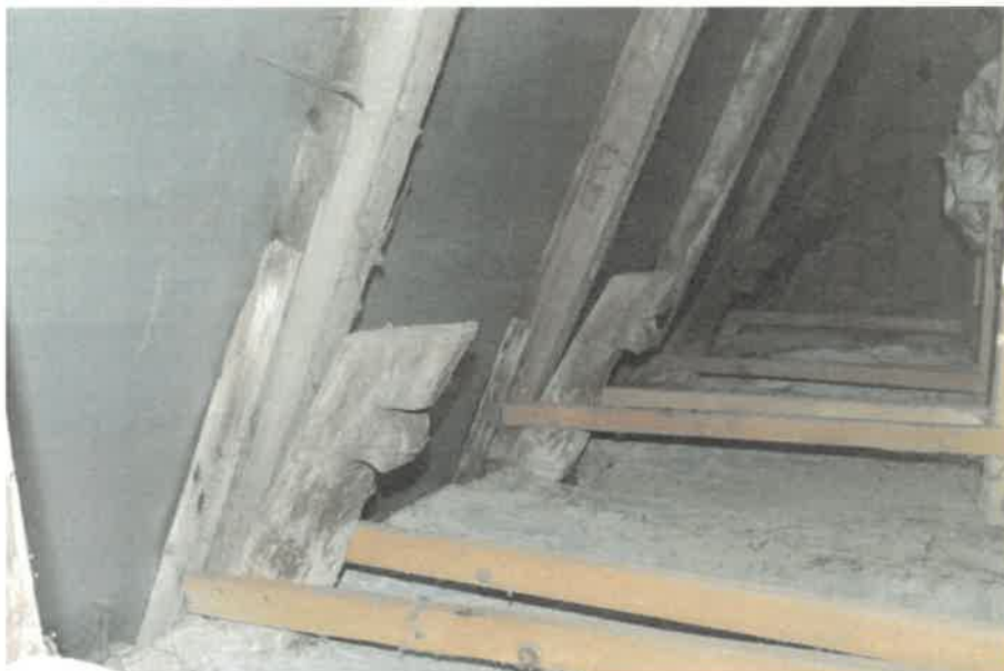
7. Faragott díszítésű eredeti szarufavégek a keleti lakóegység toldalékhelyiségének padlasterében
