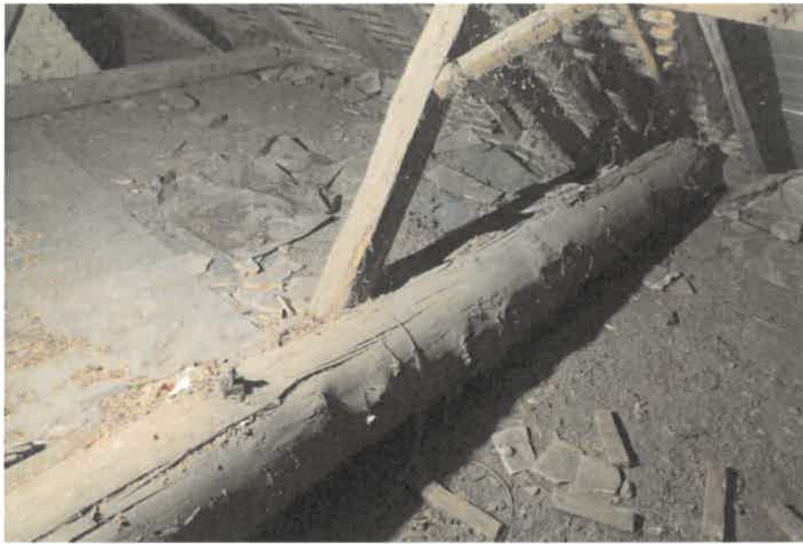
30. Padlástér a keleti épületrész felett, a mestergerendát tartó fatörzs a felkötőcsavarral
