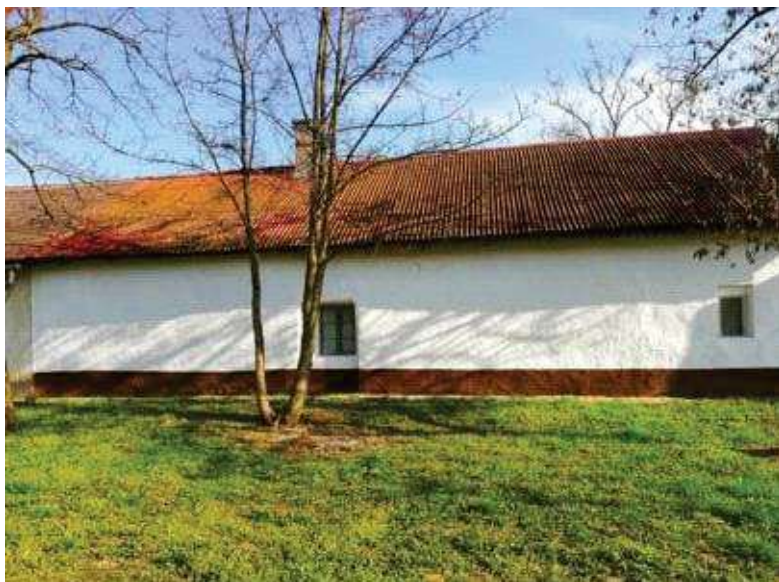
37. Fénykép a legutóbbi átalakítást megelőző időszakból, a 2000 körüli évekből
