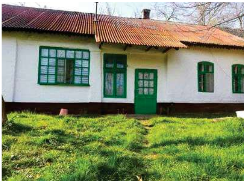
36. Fénykép a legutóbbi átalakítást megelőző időszakból, a 2000 körüli évekből
