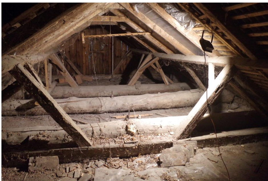
29. Padlástér a keleti épületrész felett, a mestergerendát tartó fatörzsek
