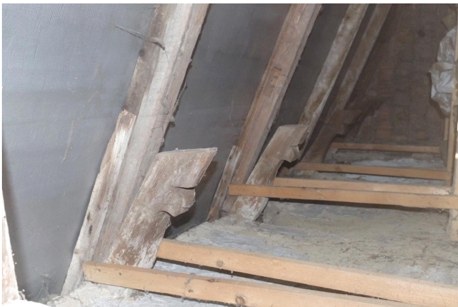
7. Faragott díszítésű eredeti szarufavégek a keleti lakóegység toldalék helyiségének padlásterében
